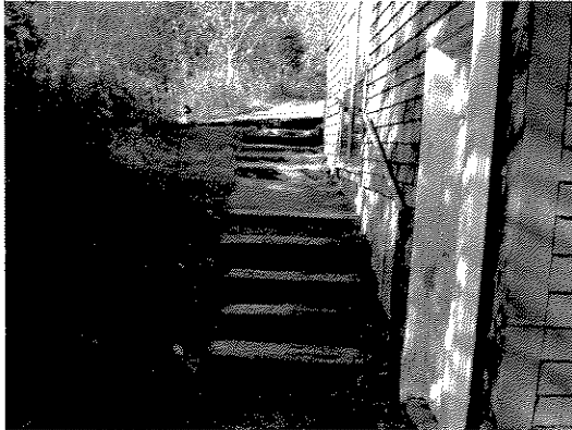
094 Side Exterior Stairs
